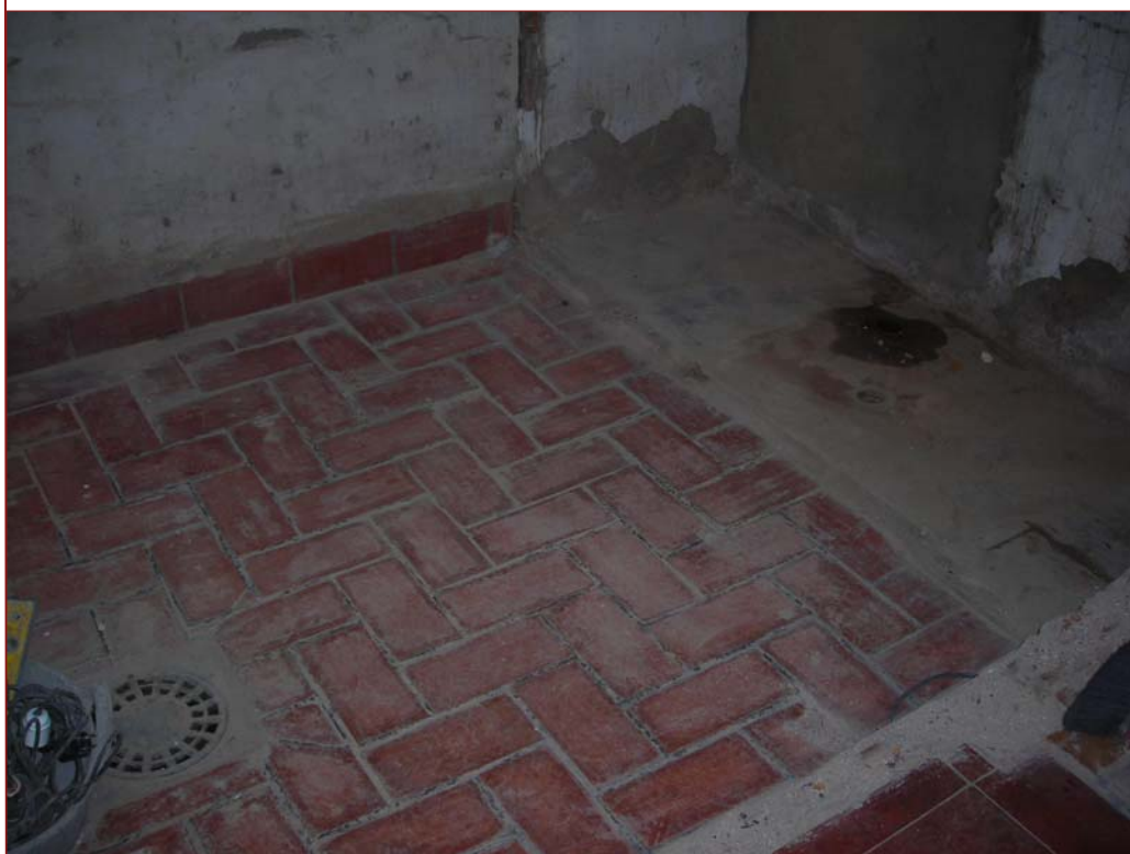
Foto 2. Paviment (UE 01) del pati interior.
