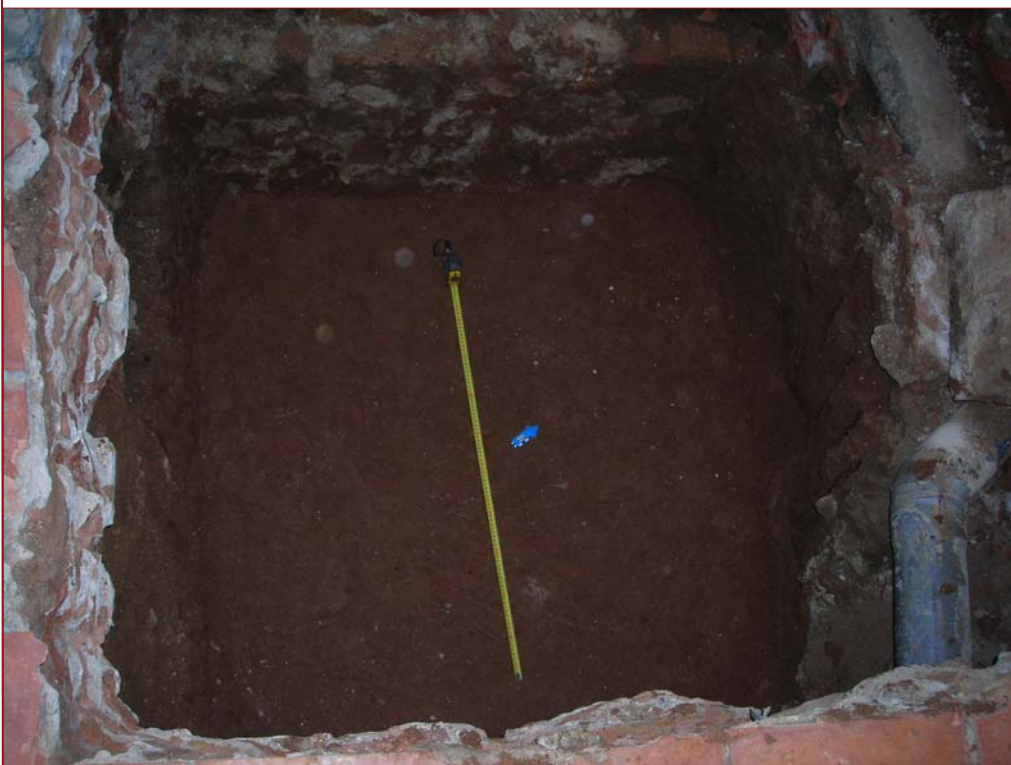
Foto 9. Cota final d'excavació.
