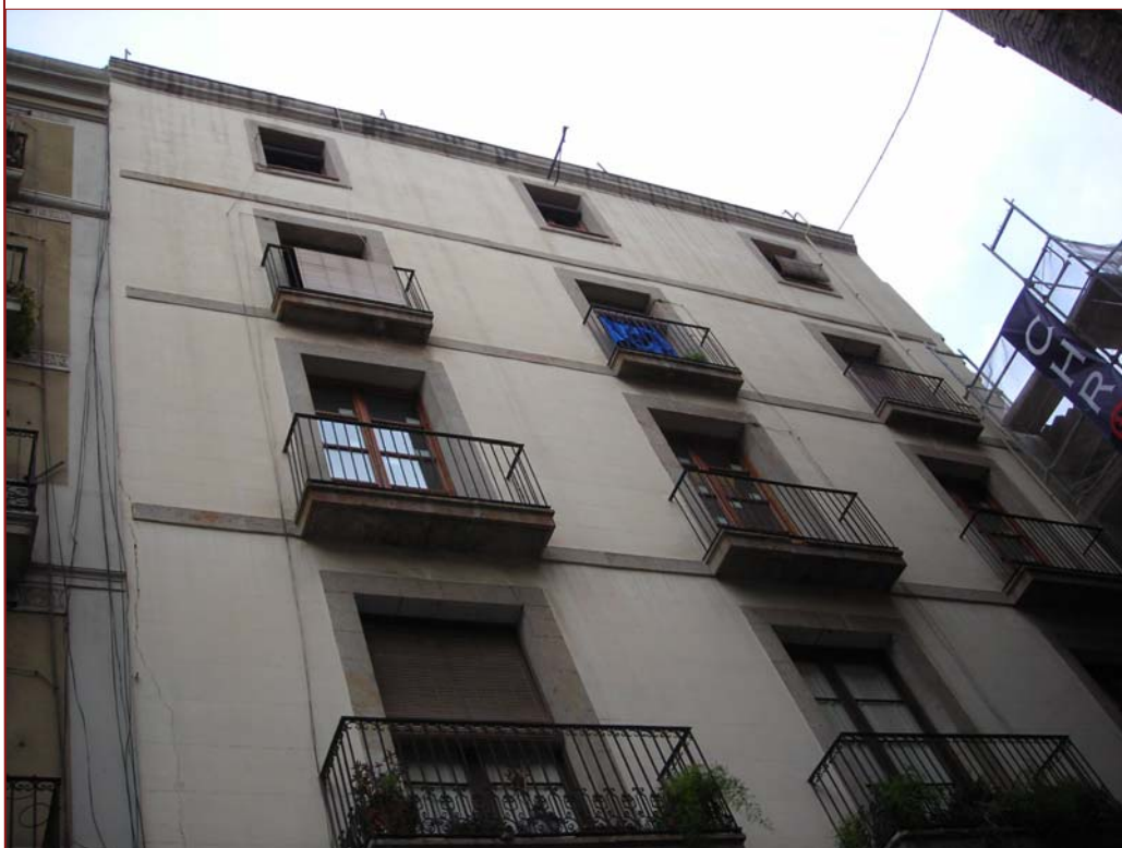
Foto 1. Façana de l'edifici nº19 del c/Cardenal Casañas.
